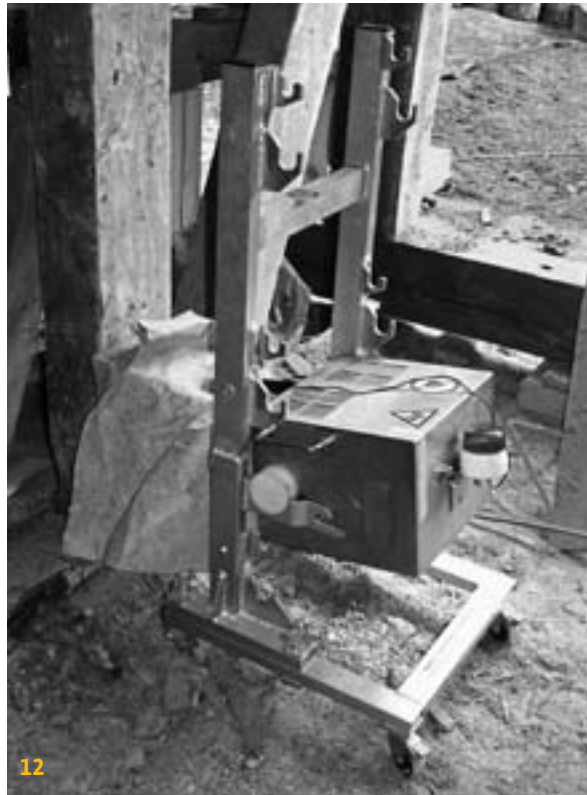
12 Mikrowellen-Strahler beim Einsatz gegen Holzschädlinge. (Foto: Stefan Haar)
