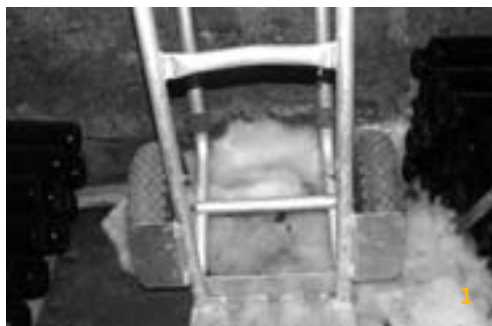
1 Zuckerwatte im Weinkeller? ...oder doch Luftmyzel des Echten Hausschwamms?
